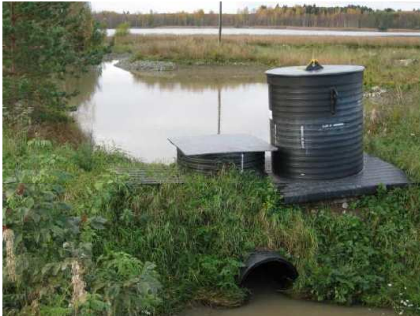
Kuva 10. Esimerkki ojaan rakennettavasta fosforisiepparin ja laskeutusaltaan yhdistelmästä. 3
