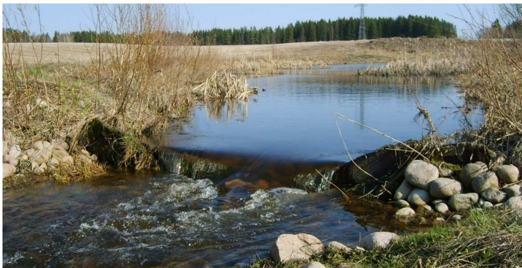
Kuva 9. Hattulan Lehijärveen laskevaan Myllyjojaan toteutettu pienten pohjapatoaltaiden ketju.
